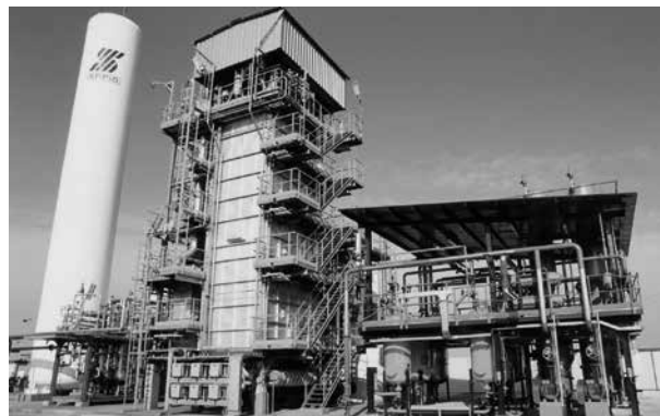
Impianto di produzione idrogeno da steam methane reforming di Mantova
