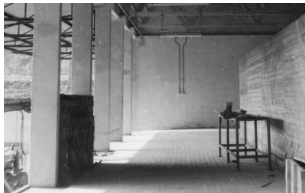
Particolari d'impianto di produzione anni '40-'50
